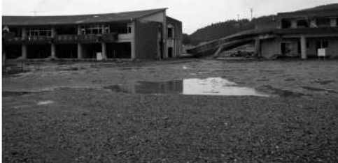
写真は大川小学校：渡り廊下が崩壊、右手に山があるが、児童に登れるか？
