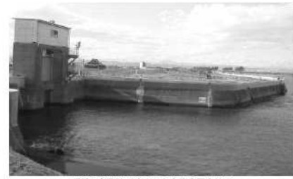
堤防の復旧が完了した名取市閉上地区
